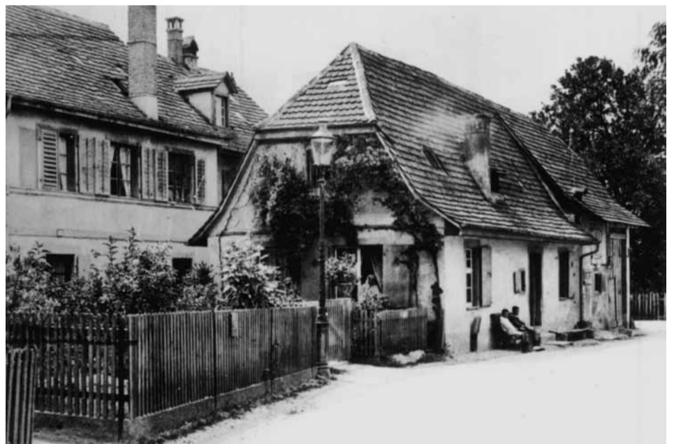
1999 wurde das Fischerhaus Bürgin am alten Standort (unten) in seine Teile zerlegt. Die Balken wurden fein säuberlich nummeriert und in Container verpackt. Bereits im folgenden Sommer begann der Wiederaufbau am jetzigen Standort. Und so präsentiert sich das Fischerhaus Bürgin heute (oben).
